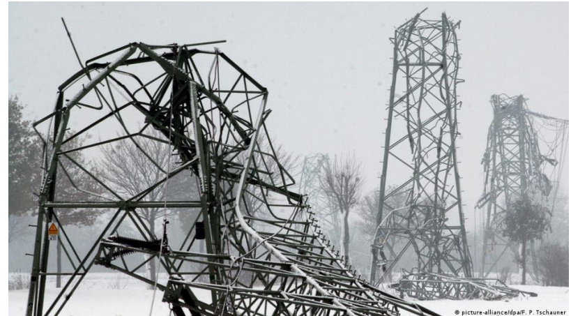
Abbildung 1: Umgeknickte Strommasten im Winter 2005 (Ralf Bosen, DW, „Blackout-Experte: Stromausfall stoppt nicht an deutschen Grenzen“, 2018)
